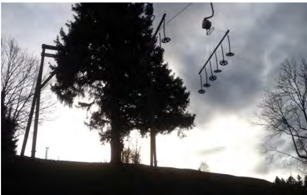
Bild 35: Dorflift und Skipiste (Skizze und Foto) Der in Eigeninitiative gebaute und konstruierte Schleplift am ‚Seeger Berg‘ ist im Winter noch in Betrieb
