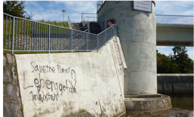
Bild 69: Stau und Wehr Wasserkraftwerk am ‚Rottauensee‘ bei Hebertsfelden, Gemeinde Postmünster
