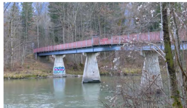
Bild 33: Auf der Brücke (Skizze und Foto) Mit Banknischen ausgestattete Rad- und Fußgängerbrücke über die ‚Saalach‘ verbindet Piding mit ‚Schwarzbach‘ und ‚Türk‘
