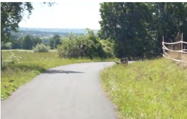
Bild 26: Rastbank am Radweg Weilersbach Richtung ‚Schweizer Keller‘
