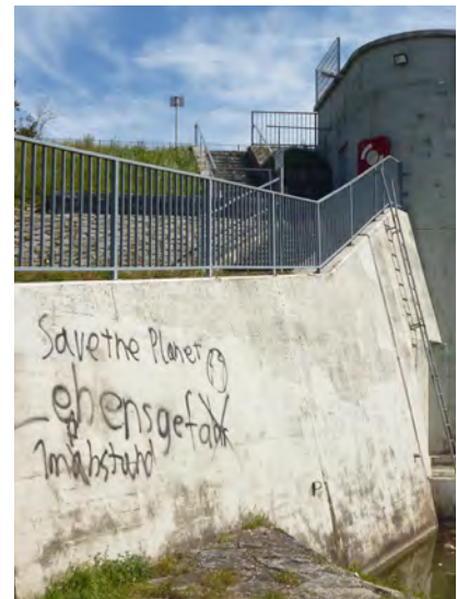
Bild 3: Wasserkraftwerk am ‚Rottauensee‘ in Postmünster (Niederbayern)
