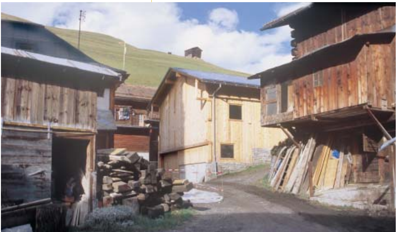
Weiterbauen in der Kulturlandschaft – diesen umfassenden Ansatz dokumentieren die Bilder von Vrin/Graubünden, wo es gelungen ist, über lange Zeiträume durch die Neubebauungen die Struktur des Dorfes weiterzuentwickeln. Architekt: G. Carminada, Conz
